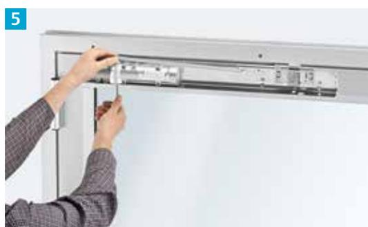
6 Montage der Gleit-schiene
